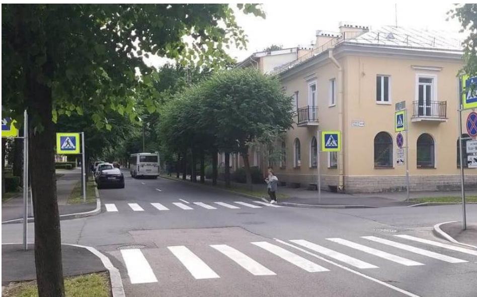
Обустройство переходов Конюшенной ул. с ул. Первого Мая и Песчаным пер. в г. Павловске в результате обращений к Администрации Пушкинского района Санкт-Петербурга и СПб ГКУ «ДОДД». Санкт-Петербург, Пушкинский район, г. Павловск. 2020 г.
